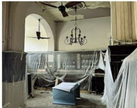
Abbandono Gli interni delle Giubbe Rosse adesso. Dal 13 giugno via ai lavori di ristrutturazione
